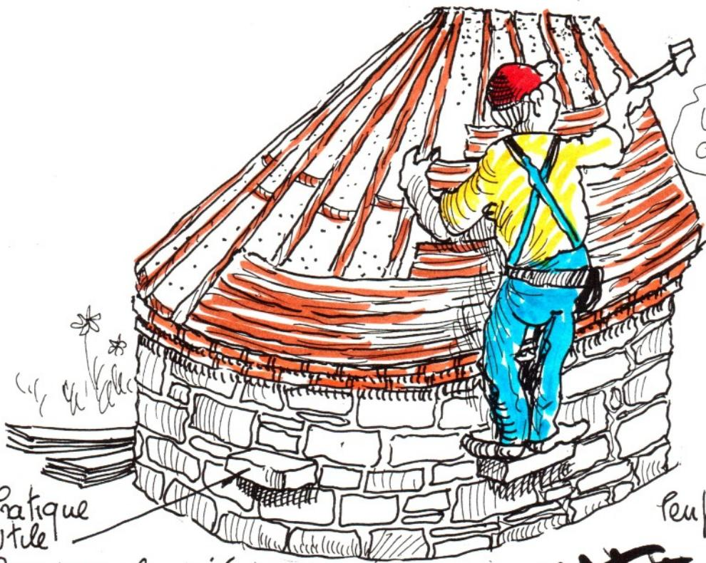
Realisation de la charpente et pose d'un Voligeage Jointif en bois tendre
