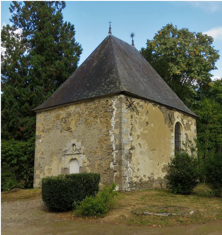
La chapelle du château des Onglées, à l'ouest d'Acigné.
