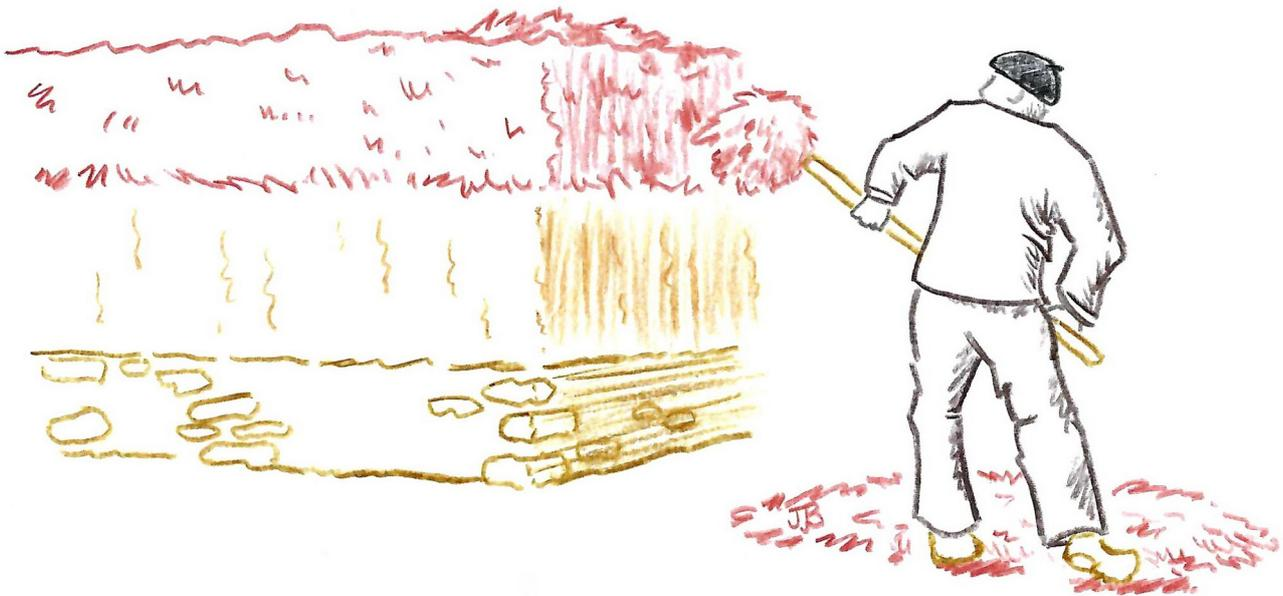
C'est, en général, le personnel de la ferme qui assure le couchage de la bauge et la monte sur le mur, tandis que le maçon est juché dessus, surveillant le travail et répartissant correctement la bauge.
