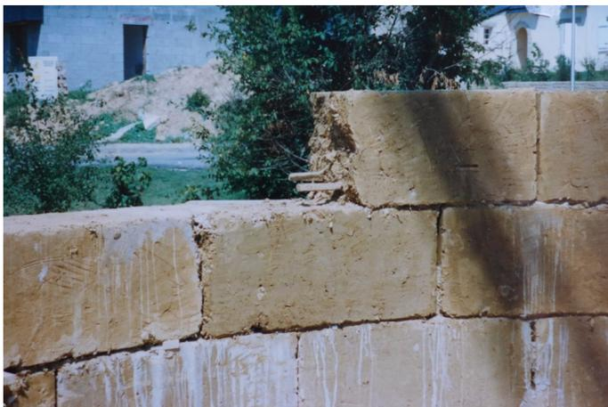
Les cubes de bauge sont en terre mélangée à de la paille et sont moulés avant d'être mis à sécher six semaines sous un hangar.
