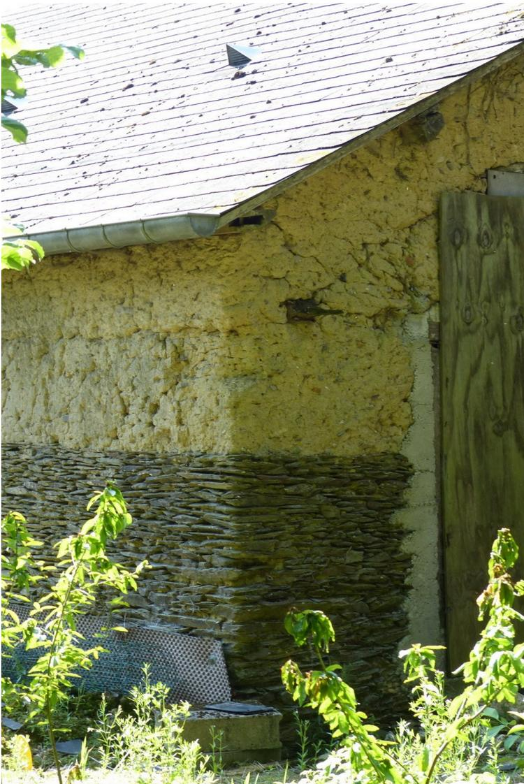
**Soubassement d'un bâtiment agricole à la Ville Aubrée.** Le soubassement est exécuté en fonction de l'utilisation de la construction et bien sûr en fonction des moyens financiers. Par exemple, pour une étable, on monte le soubassement à 1m50 pour éviter que les bêtes n'abîment la paroi. Les pierres sont liées par un mortier de chaux et sable ou par de l'argile humidifiée.
