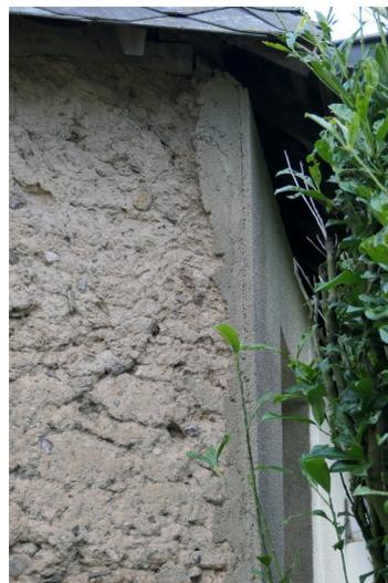
Angle d'une habitation en bauge à La Timonière. Les fourchées de bauge de la construction du mur réapparaissent. Le ciment plaqué sur la surface de la façade lui donne une allure bien différente. Mais ces enduits imperméables empêchent le mur de respirer, lui enlevant une partie de son avantage. De plus, la condensation à l'interface terre-ciment peut le dégrader,
