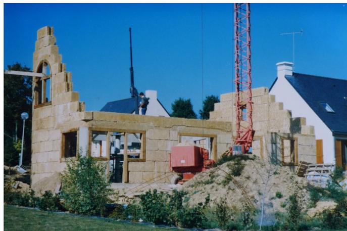
La grue permet de positionner les blocs, qui sont posés sur un lit de mortier à la chaux. Le tout est recouvert d'un enduit de sable + chaux + terre.
