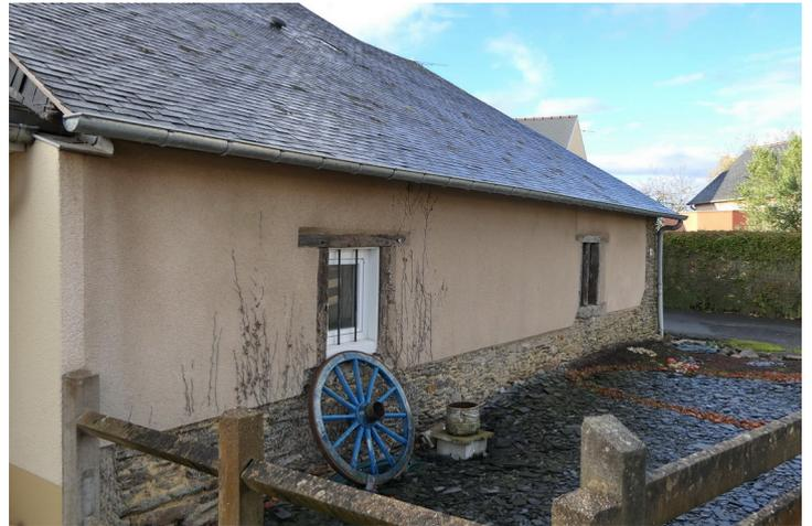
Rue de Rennes, la bauge n'est plus apparente mais la structure du bâtiment, avec le solin et les carrés de fenêtres, est révélatrice.
