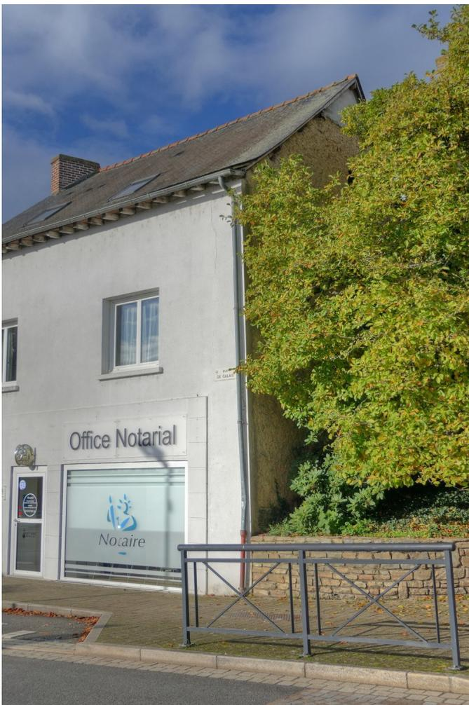
Au bas de la rue de Calais, la façade modernisée et recouverte d'un fort enduit de surface en ciment ferait presque oublier qu'elle est en bauge. Le pignon, derrière l'arbre, ne laisse pas de doute.
