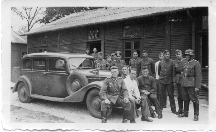
Dans le camp de munitions occupé (id.)
