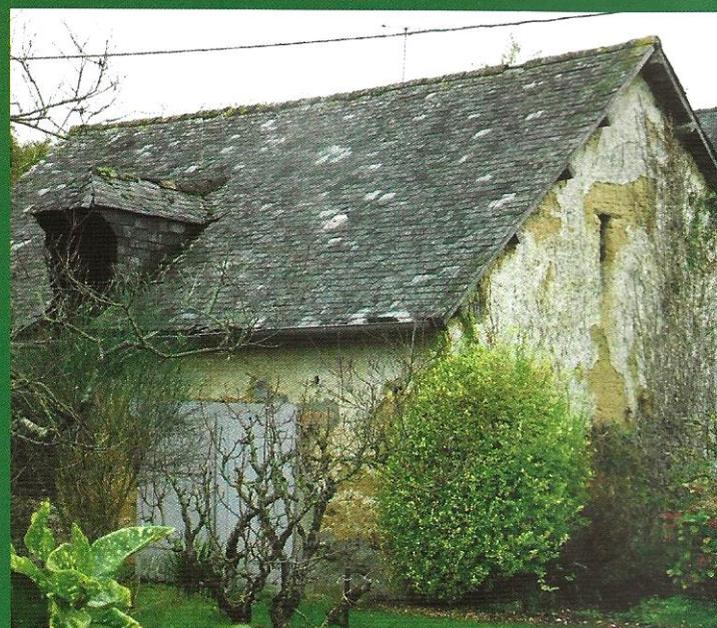
*Hangar en bauge centenaire dans le bourg d'Acigné. On aperçoit la terre sous l'enduit écaillé.*
